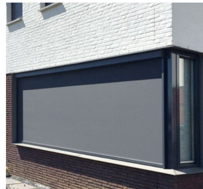
montiert am Fenster
